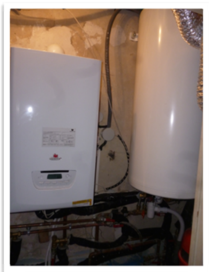
Le ballon tampon et la chaudière condensation Saunier Duval THEMA AS CONDENS 25KW + ballon préparateur FE 120 litres
