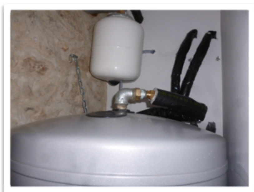
L'échangeur solaire ALLIANTZ avec ballon 200 litres simple échangeur + le vase d'expansion Kit solaire
